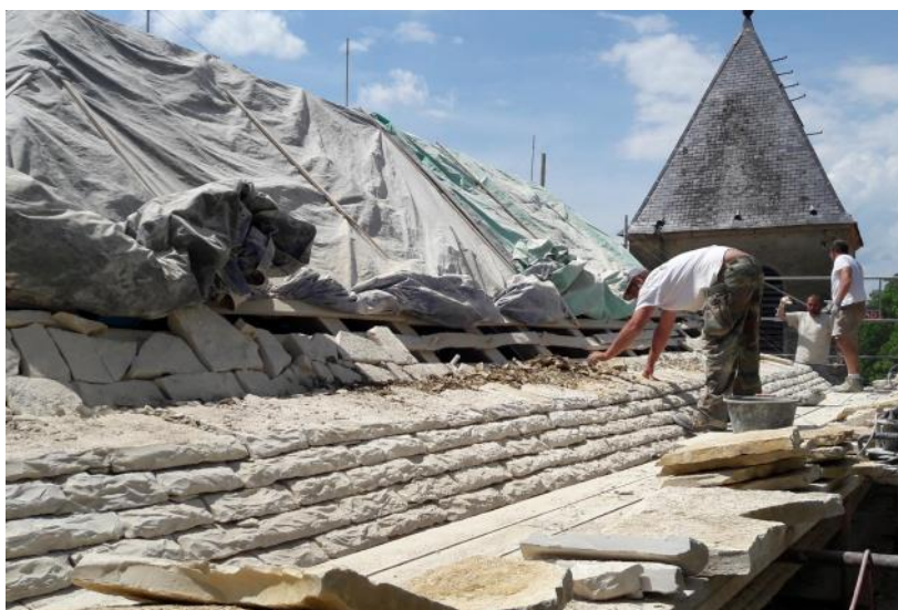
Eglise de Fresnes : Pose des laves
